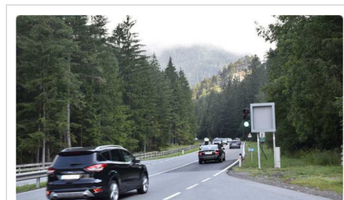
Am Nassereither Kettenanlegeplatz wurde eine Ampel samt dynamischer Anzeigetafel installiert. © Paschinger
